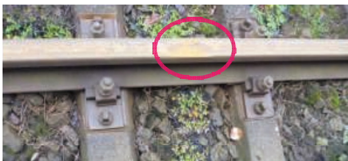
3. Widoczne miejsce wyboksovania (wady eng. „squat”) w szynie w pobliżu słabo umocowanego podkładu
