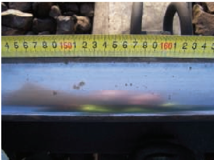
3. Miejscowe wgniecenia powierzchni tocznej szyny - Belgrospi (lato 2015; linia kolejowa nr 131)
