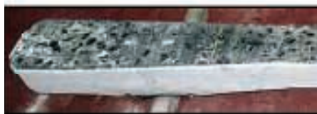
2. Podkład strunobetonowy z izolacją antywibracyjną o sztywności 35 kN/mm wybudowany z toru po 36 miesiącach eksploatacji [5]
