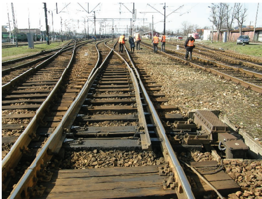
3. Rozjazd przed wymianą
