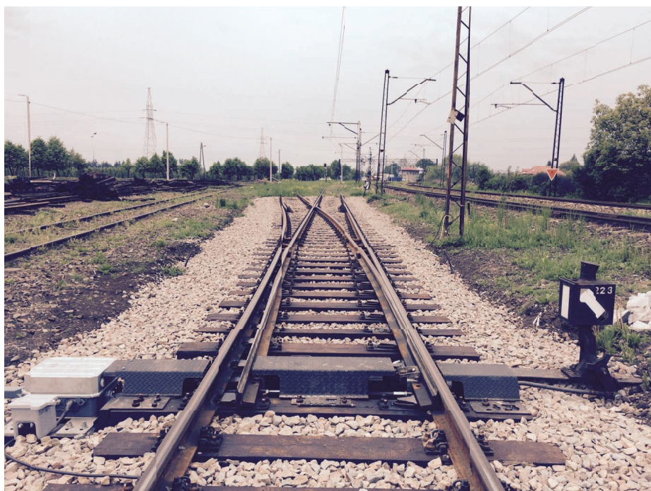
5. Rozjazd po wymianie połączony z istniejącą infrastrukturą
