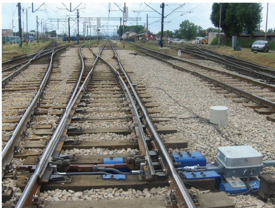
4. Rozjazd po wymianie
