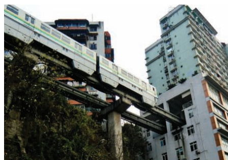
3. Kolej siodłowa przechodząca przez budynek w Chongqing [12]
