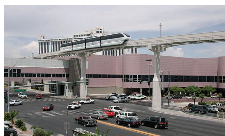
2. Kolej siodłowa przechodząca ponad budynkiem w Las Vegas [30]
