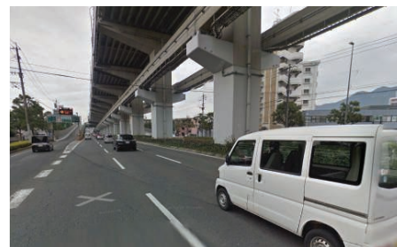
19. Wspólne podpory autostrady i kolei siodłowej w Kitakyushu [14]
