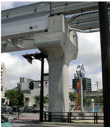
23. Początek stalowego przęsła o zwiększonej sztywności [26]
