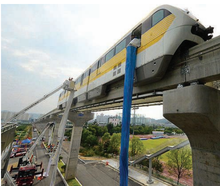
31. Próba ewakuacja z pociągu monorail w Daegu [20]
