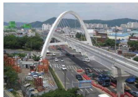
25. Most podwieszony o łukowym pylonie Manpyeong w Daegu [2]
