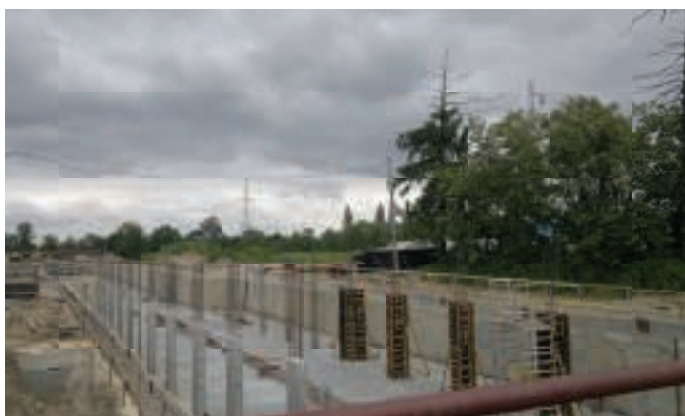
6. Budowa wykopu obudowanego pod SST w Szczecinie-Zdrojach
