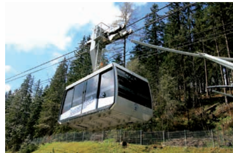
6. Kolej linowa na Kasprowy Wierch [6]
