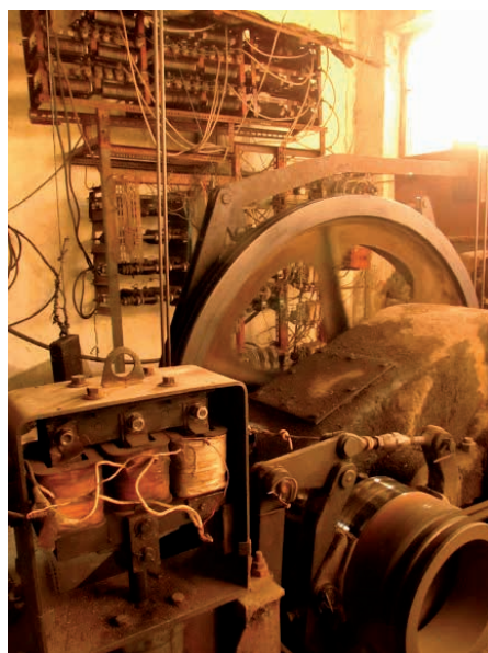
23. Urządzenia napędzające kolejki w Gruzji w Cziatura [24]
