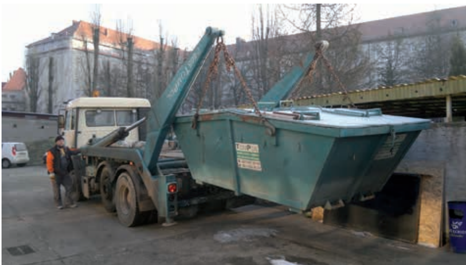
8. Odbiór odpadów remontowo-budowlanych na terenie ZUT w Szczecinie
