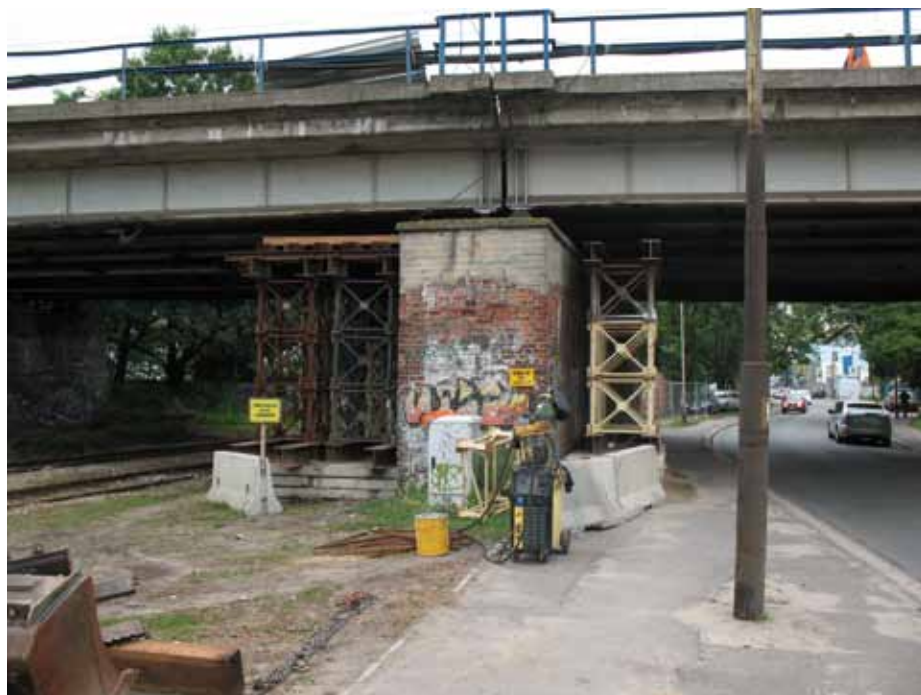
3. Zdjęcie z realizacji przedstawiające oba typy klatek podporowych
