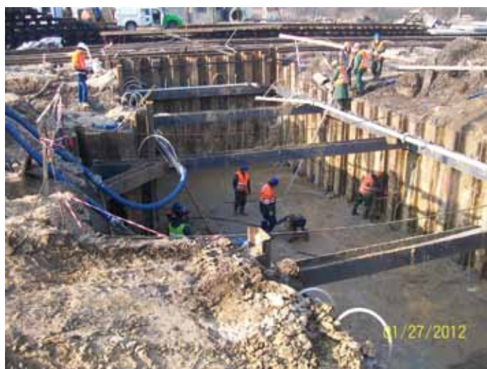
10. Zdjęcie z realizacji przejścia na stacji Żmigród pokazujące układ ścian szczelnych oraz rozpór.
