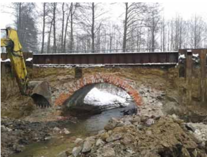
6. Zdjęcie z realizacji pokazujące istniejące sklepienie (w trakcie rozbiórki) oraz wbudowaną konstrukcję odcciążającą
