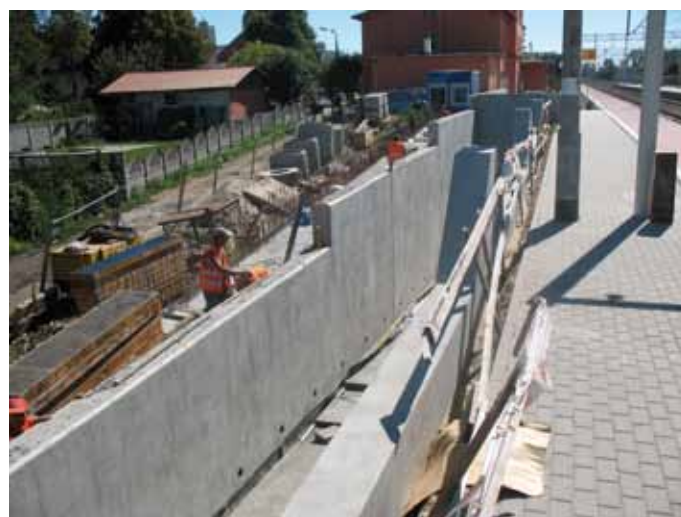
11. Zdjęcie z realizacji przejścia stacji Żmigród pokazujące nowo wykonane segmenty
