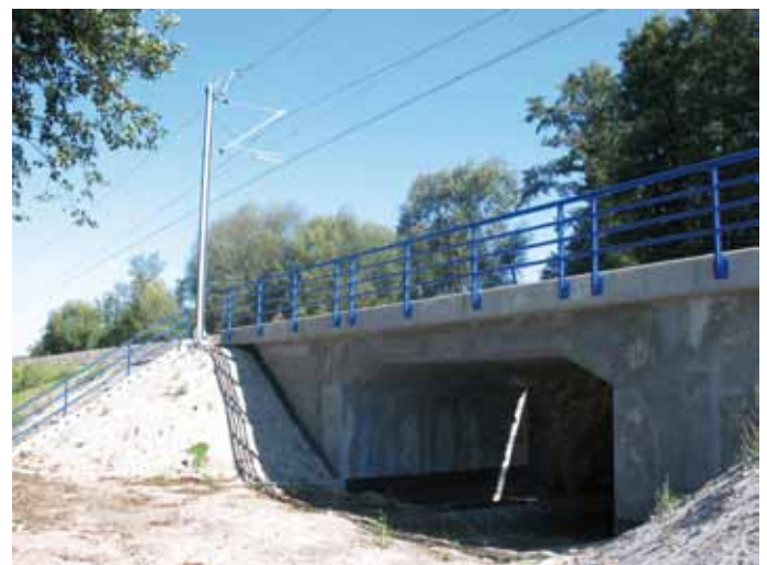
7. Zdjęcie z realizacji pokazujące nowo wykonany obiekt w torze nr2
