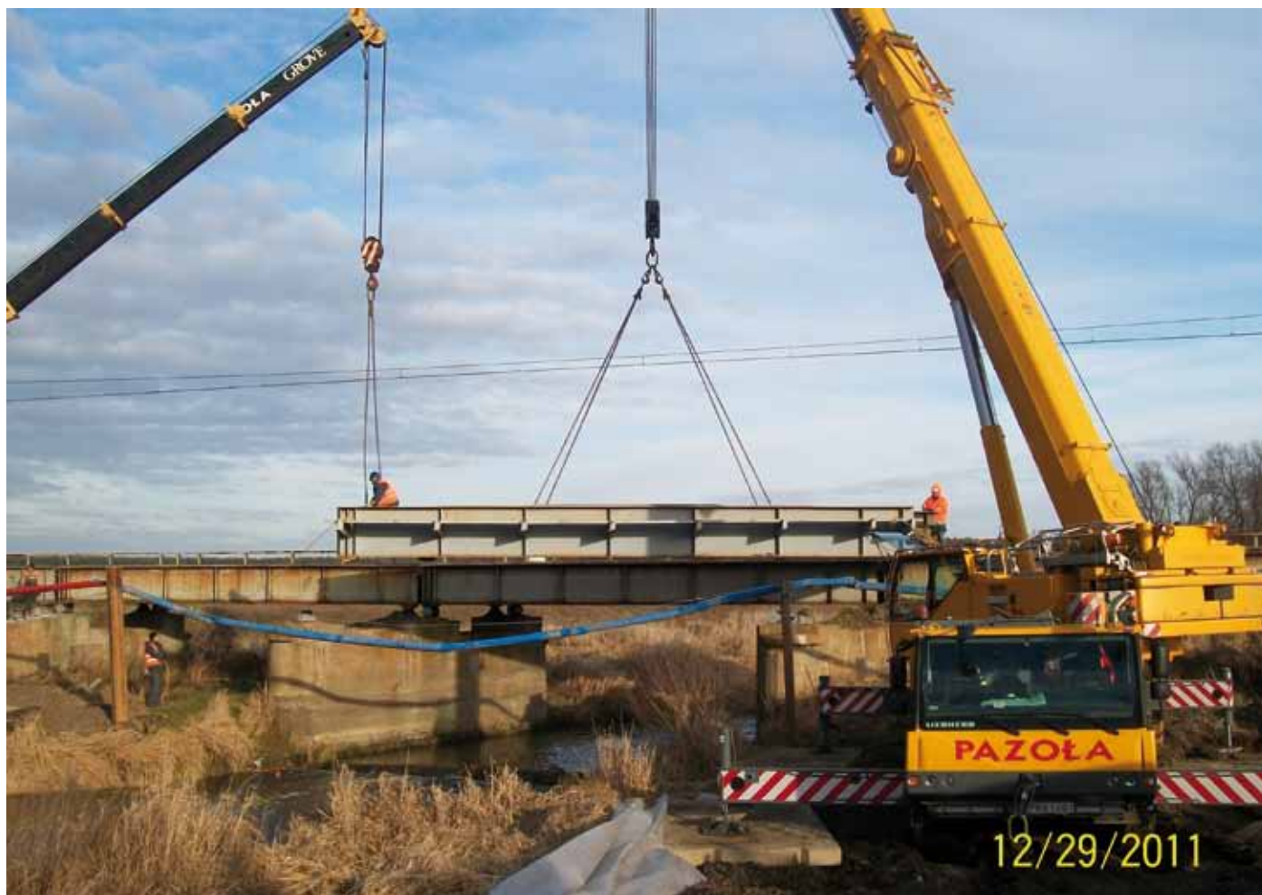
16. Zdjęcie z realizacji mostu nad rzeką Barycz pokazujące demontaż przęsła blachownicowego przy użyciu żurawia kolejowego EDK-300/5
