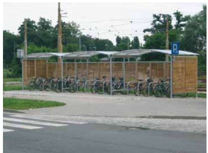
3. Zadaszony parking na pętli tramwajowej Leśnica
