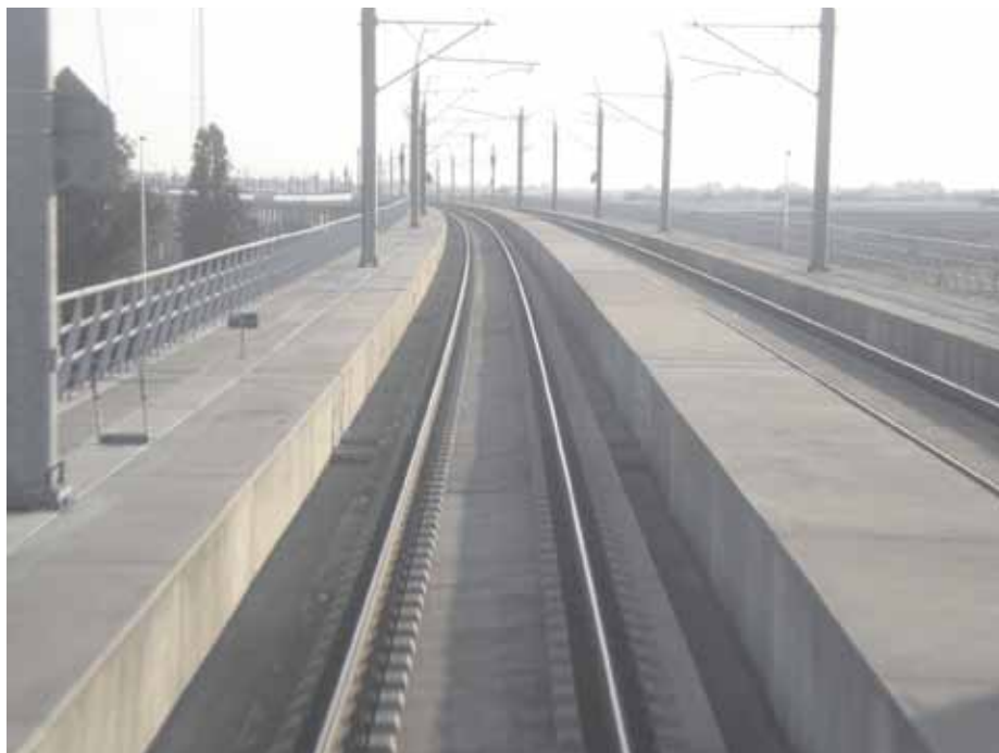
1. Widok toru z nawierzchnią niekonwencjonalną na linii dużych prędkości w Holandii (fot. A Massel)
