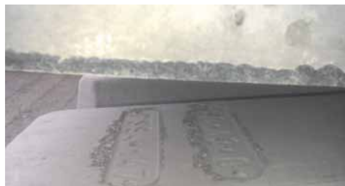
8. Podkład strunobetonowy z wibroizolacją typu PS94 147
