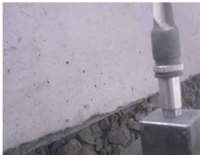
7. Czujnik przyspieszeń pionowych na poziomie wibroizolacji podkładu strunobetonowego
