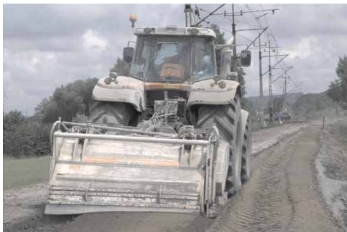
3. Mieszanie spoiwa z gruntem
