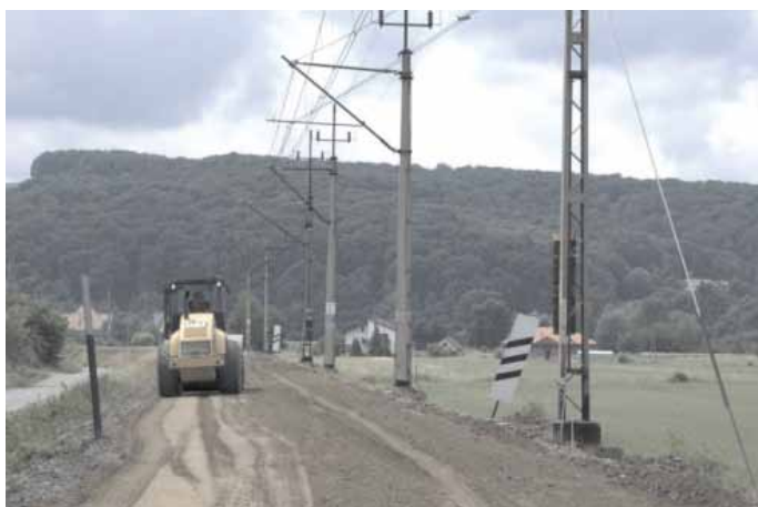
5. Zagęszczanie gruntu walcem wibracyjnym
