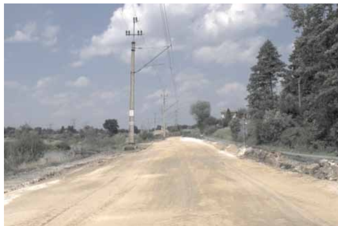
6. Odcinek stabilizowany wapnem palonym, przed jego ostatecznym wyprofilowaniem
