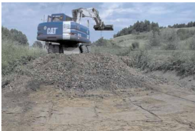
1. LK 96. Pierwszy etap po rozebraniu torów i podkładów – usuwanie podsypki
