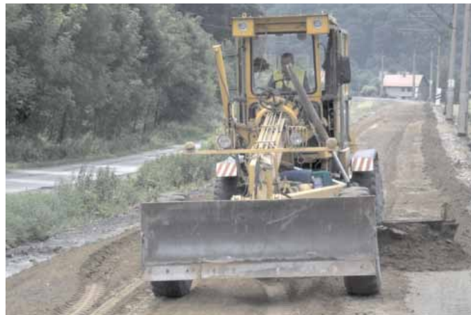
4. Wyrównywanie podtorza równiarką
