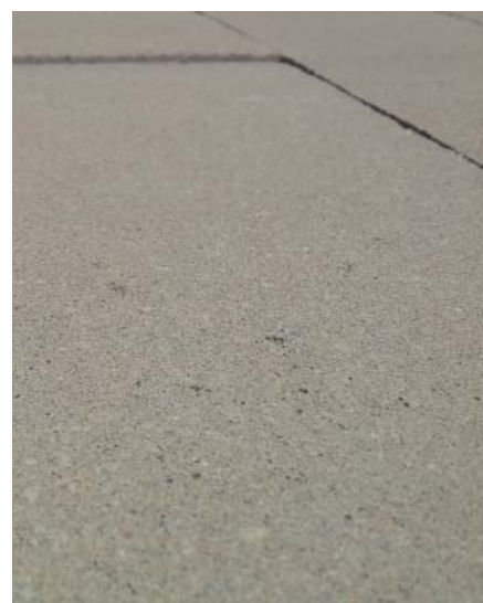
1. Wygląd nawierzchni z betonu wibroprasowanego
