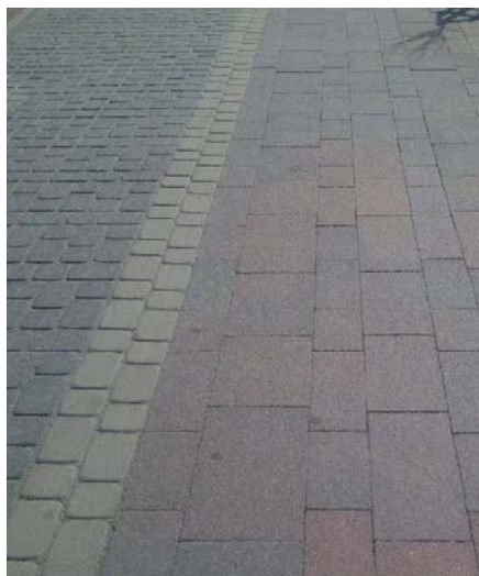
6. Widok ścieżki rowerowej z nawierzchnią, z betonowej fotokatalitycznej kostki brukowej produkcji ZPB Kaczmarek ułożonej w Zielonej Górze
