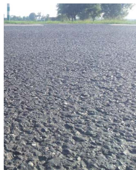
2. Wygląd nawierzchni z asfaltobetonu
