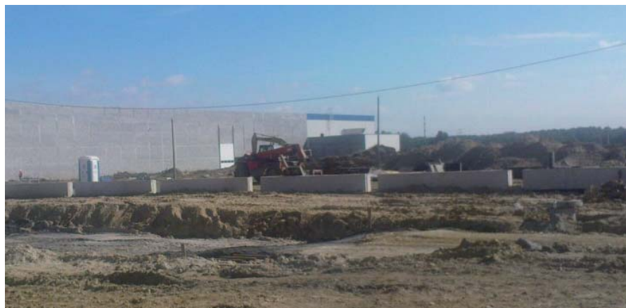
1. Koryto drogi – odcinek monitorowany, droga w trakcie realizacji
