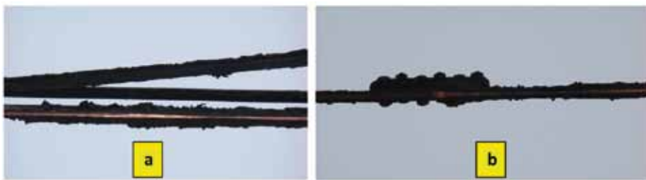
14. Pozostałości smaru grafitowego na przewodzie jezdnym sieci trakcyjnej: a) - przewód jezdny toru zwrotnego na rozjeździe sieciowym, b) - zacisk przewodu jezdniego.
