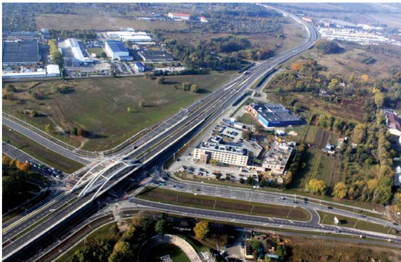
7. Wiadukt nad ulicą Żmigrodzką z lotu ptaka
