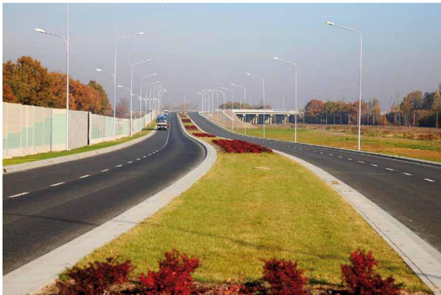
1. Dojazd do Mostu Milenijnego
