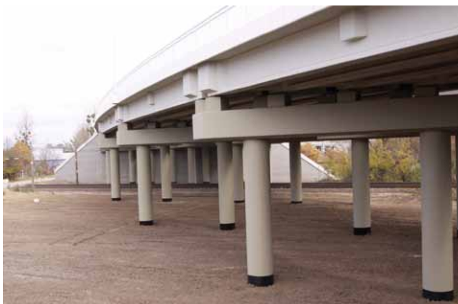
4. Estakada nad linia kolejową
