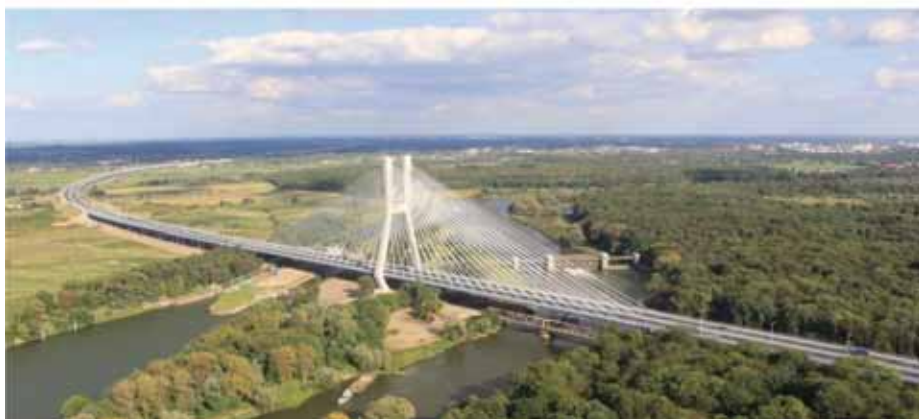
12. Zdjęcia wybranych etapów budowy mostu i widok gotowego obiektu
