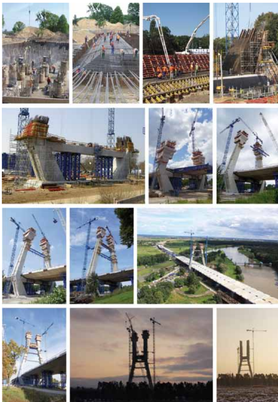
7. Zdjęcia obrazujące proces budowy pylonu
